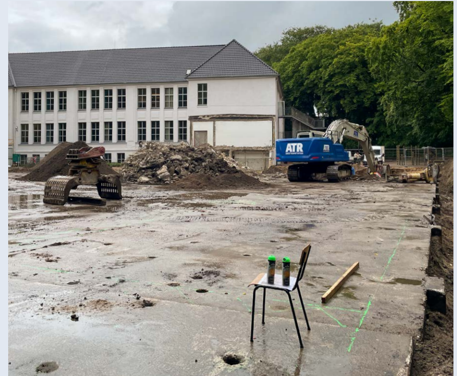
Ende Juli: Der »Schlauch« ist abgerissen, der Bagger knabbert bereits an der Bodenplatte.
