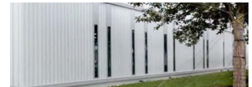
Referenzen der Architekten für den Fassadenentwurf mit Reliefglaselementen (oben) und für die schmalen, bodentiefen Fenster der Klassenräume im neuen Verbindungsbau (unten).
